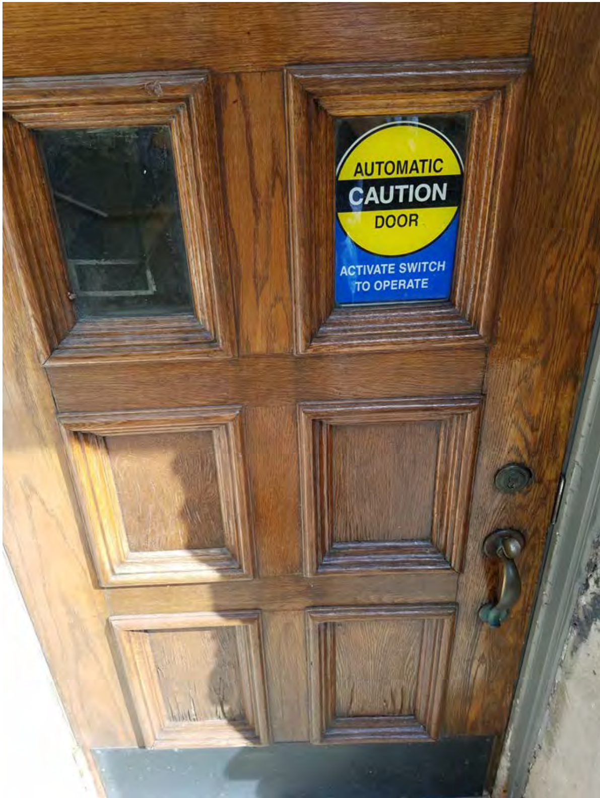
Existing alley door
