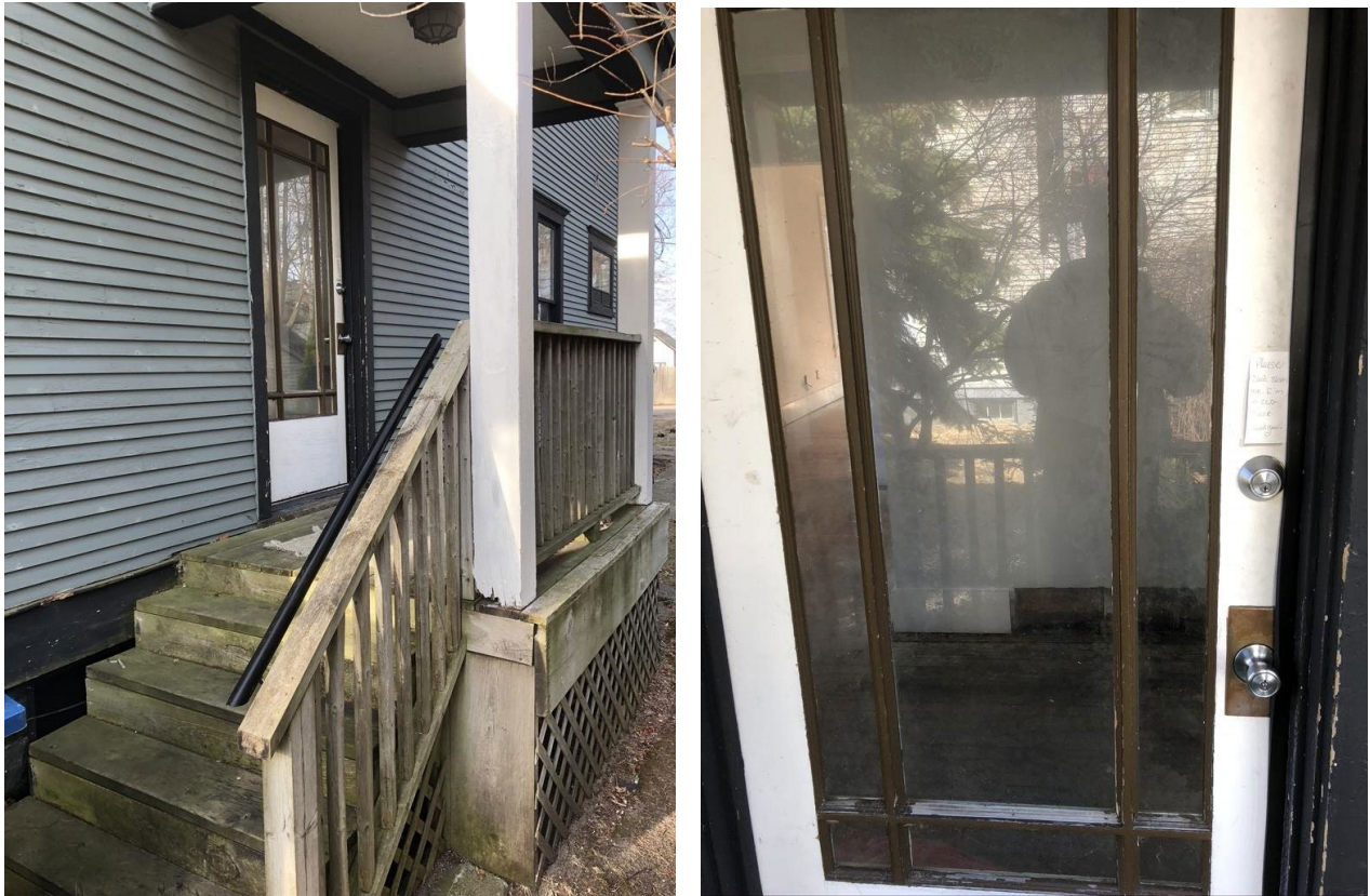
Existing side door
